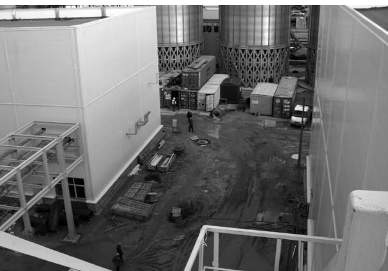
So sah die Baustelle in Russland aus...
